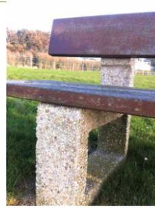
*Banc à dossier à piètement béton scellé dans une pelouse*
