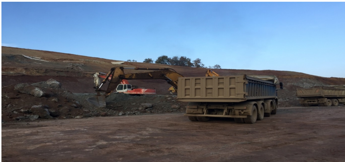
Figure 7 – Travaux de construction de l'autoroute de Grèce centrale (E-65)
