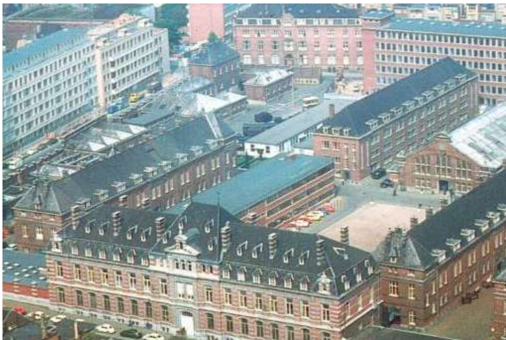
Vue aérienne de l'ancienne caserne d'Ixelles en cours de réhabilitation
