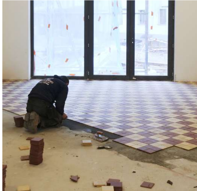
1) Illustration des principes du réemploi à travers le cas de figure d'un revêtement de sol en carrelage : démontage soigneux, nettoyage et repose.
