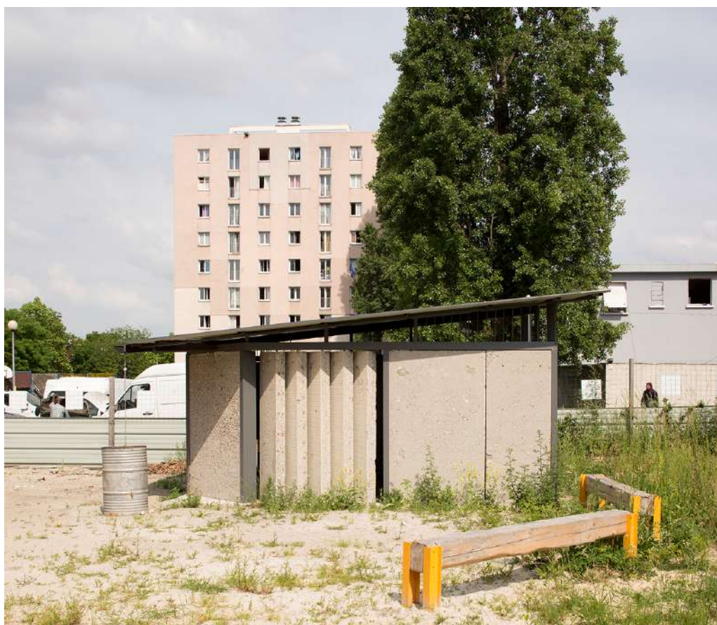
La Fabrique du Clos à Stains, déploiement de la filière réemploi de béton dans un projet de NPNRU
